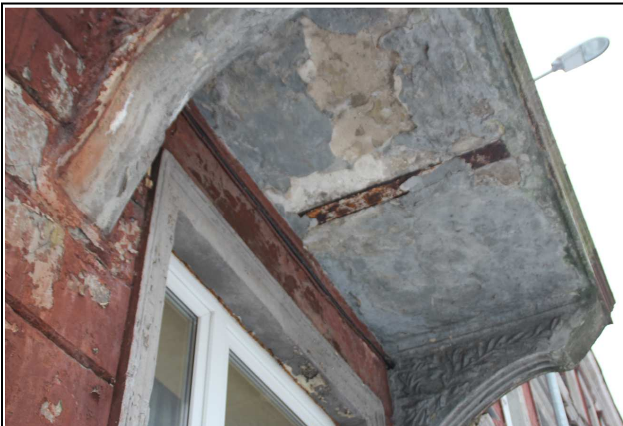
Att. 4. Atsegtais balkona nesošais centrālais dubult-T profils
