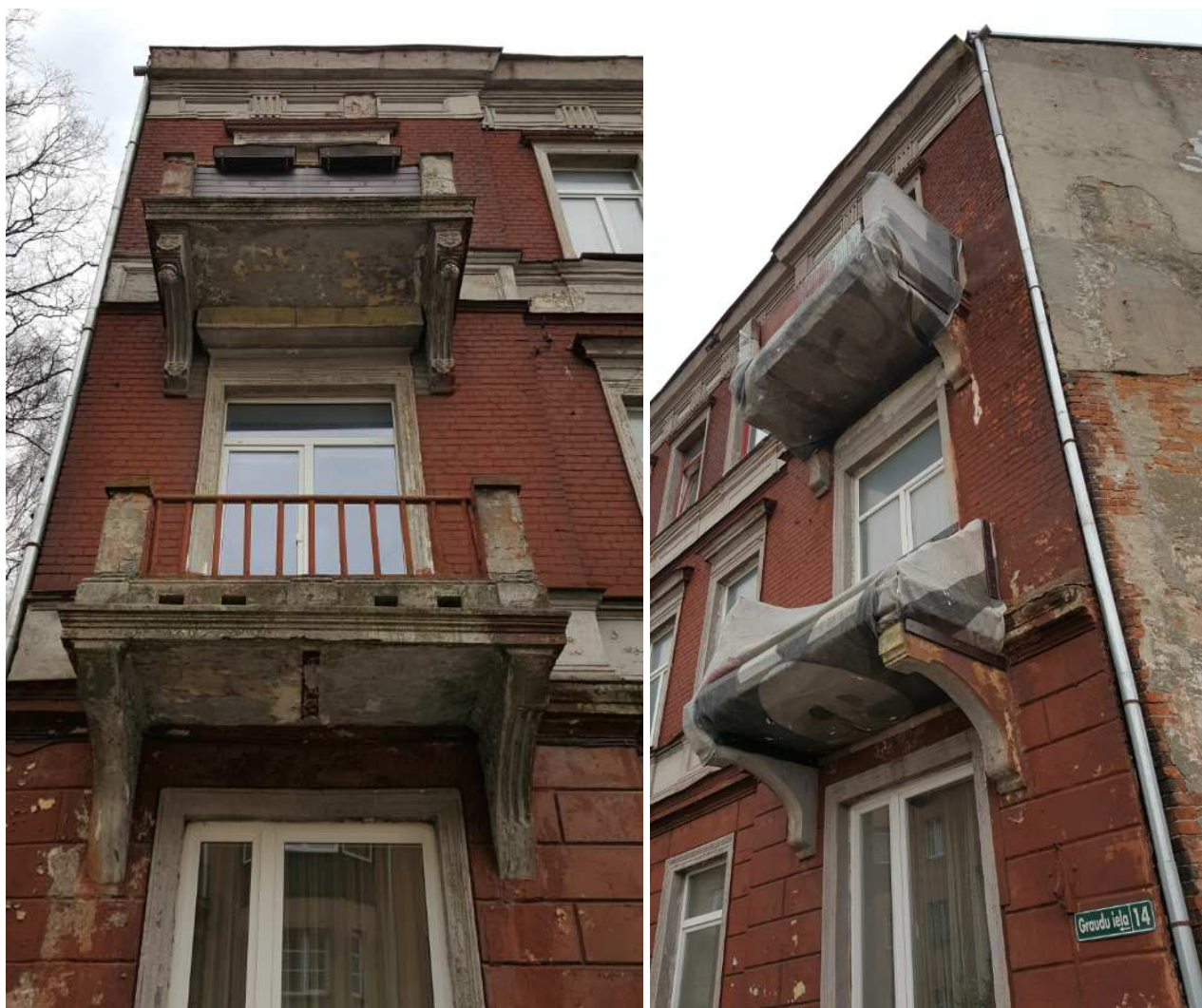
Att. 1. Apsekojamie balkoni
