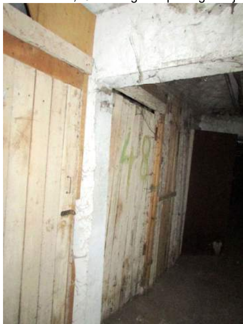
14.,15.,16.att. Saglabājamo šķūnīšu sienu augšdaļa jādemontē; pagrabā redzami nenomainīti inženiertīkli; dažas starpsienas mūrētas..
