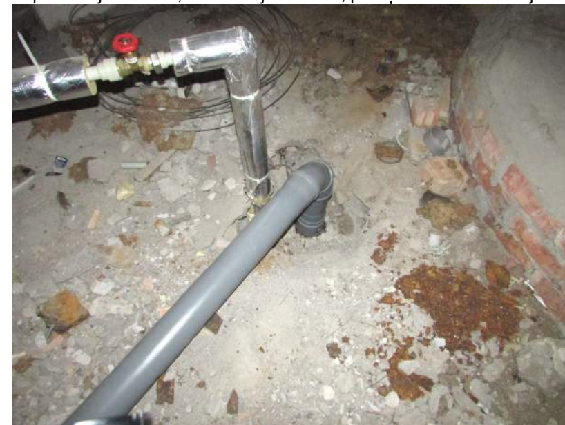
19.,20.att. Lietusnotekas nomainītas; uz siltināmā pārseguma ir kanalizācijas caurules; bēniņos ir karstā ūdens caurules, sakaru kabeļi, demontējami vecie apkures vadi..
