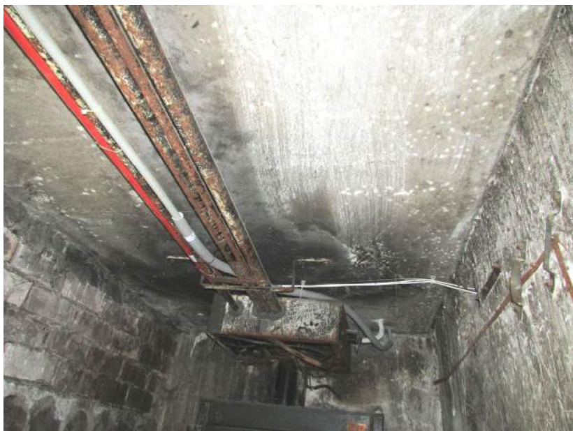
12.,13.att. Pagraba pārsegums jāsilina, atvērto kabelus no griestiem. Bojātais panelis asīs M-N/2-3 jāremontē; redzamas vairākas plaisas, bojāta virsma.
