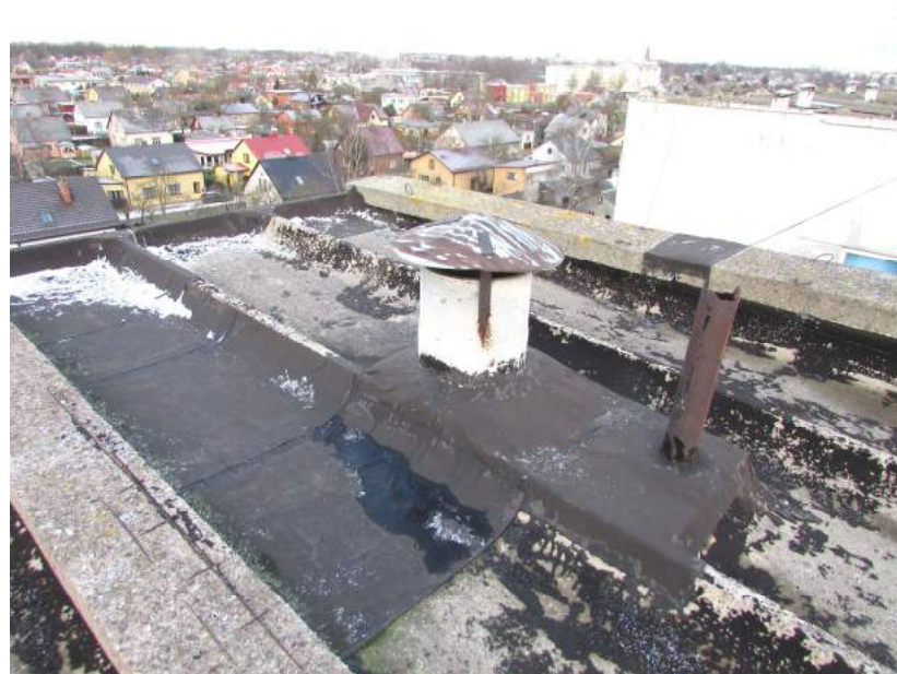
29.,30.att. Dzelzsbetona jumta kopskats; visi jumta elementi-paneļi, jumtiņi, margas, parapeti-daļēji nolietojušies; bojājumu vietas nosegtas ar ruberoīda ielāpiem.
