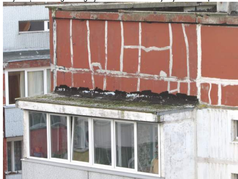
35.,36.att. Parapeti jāremontē, jāapšuj ar skārdū; pēc ruberoīda noņemšanas jāprecizē bojājumi. Uz lodžiju jumta virsmas redzams apsūņojums; segums tiks mainīts..
