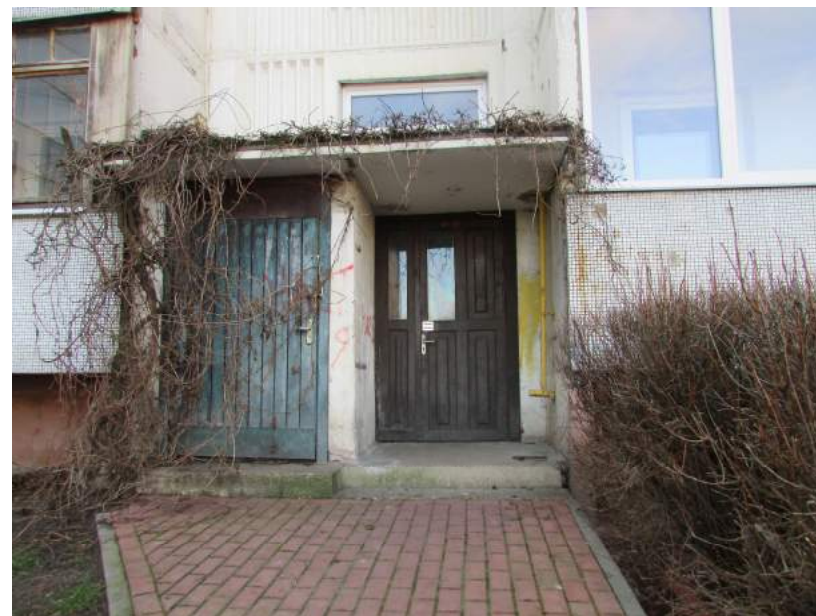
8.,9.att. Ārējiem ieeju mezgliem jāmaina ārdurvis, jāremontē pagrabu stabi, atbalstsienas, jumtiņi; lieveņi jāatjauno galvenām ieejām (kreisias attēls).
