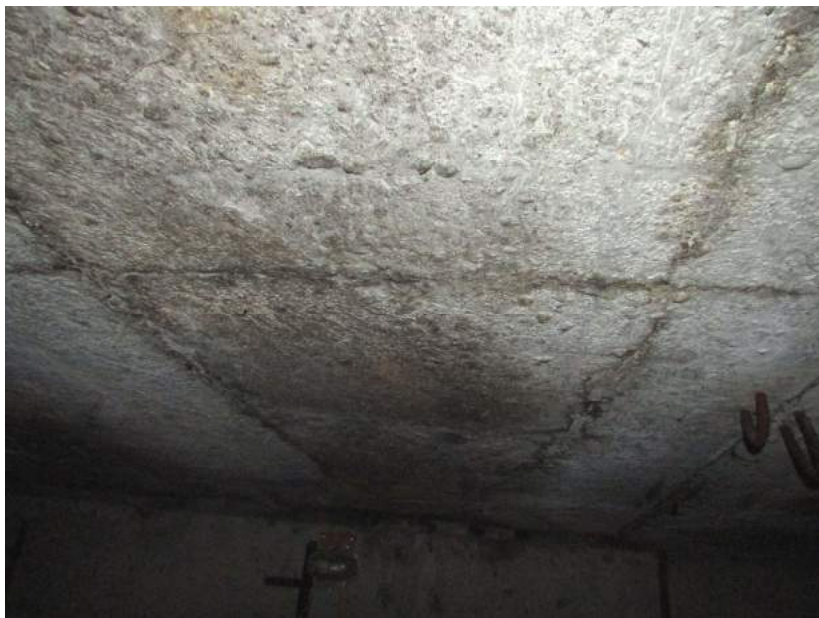
25.,26.att. Daudziem paneļiem raksturīgas plaisas, 3 tumšas joslas, betona saistvielu izskalojumi u.c.defekti, kas jānovērš remontdarbu laikā.
