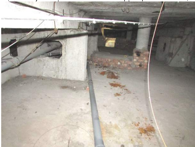
19.,20.att. Lietusnotekas nomainītas; uz siltināmā pārseguma ir kanalizācijas caurules; bēniņos ir karstā ūdens caurules, sakaru kabeļi, demontējami vecie apkures vadi..
