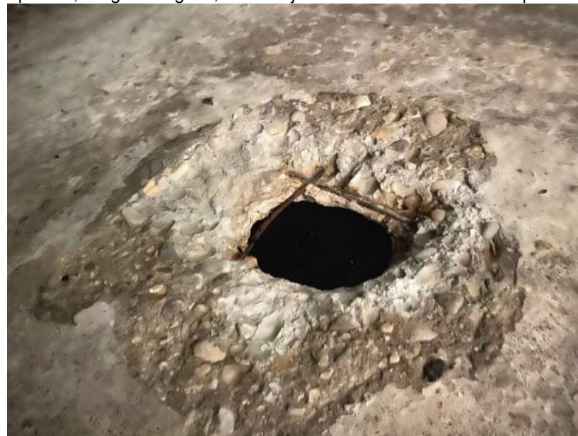
23.,24.att. Trijiem jumta paneļiem konstatēti bojājumi visā apakšējā virsmā; remonts veicams, negaidot mājas atjaunošanas darbu sākumu. Vietām paneļos ir robi.
