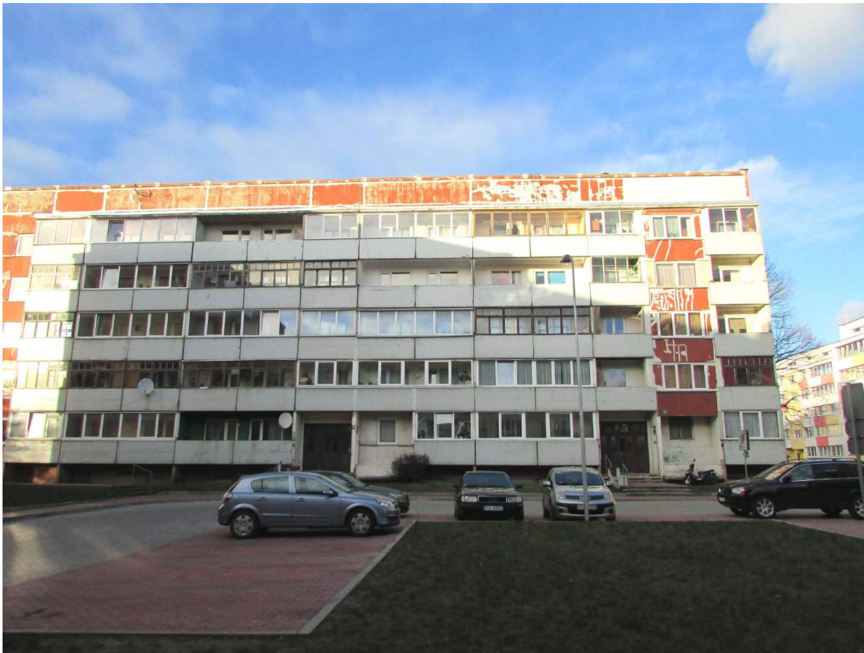
3.att. Dzīvojamās mājas D puses fasāde; redzamas divas sekcijas. Paneļu ārsienu virsma cietusi no mitruma; lodžiju margu plātnes tiks saglabātas .
