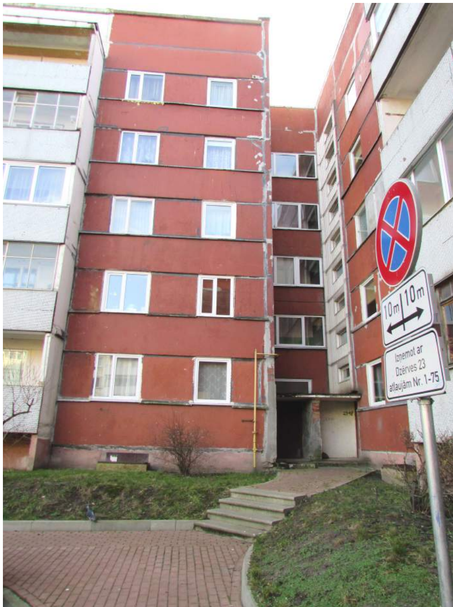
6.att. Ieeja dzīvojamās mājas 3.sekcijā; jāpārbūvē mūra sienuņa, jāremontē jumtiņš.
