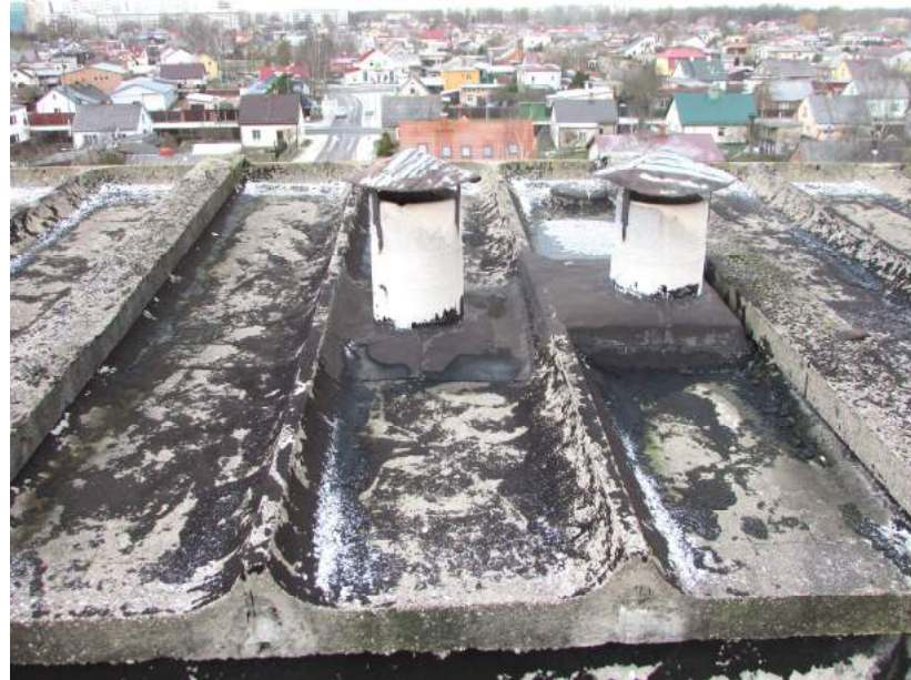
31.,32.att. Jumta elementu bojājumu apmēru jāprecizē pēc ruberoīda noņemšanas; jumtiņiem ir stiegu atsegumi; lūku vāki, skārda jumtiņi nolietojušies..
