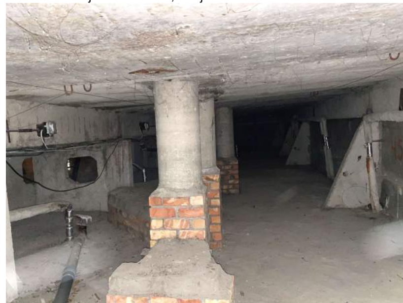
27.,28.att. Jumta paneļiem izvadu vietās atsegts stiebrojums, ir plaisas, mitruma plankumi.
