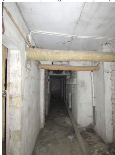
14.,15.,16.att. Saglabājamo šķūnīšu sienu augšdaļa jādemontē; pagrabā redzami nenomainīti inženiertīkli; dažas starpsienas mūrētas..
