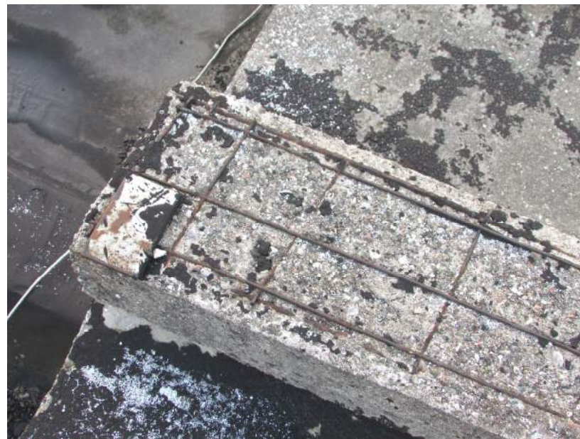
33.,34.att. Vienam panelim bojāta riba; lielākie defekti nosegti ar ruberoīdu. Vairākiem jumtiņiem atsegts stiegrojums. Jumta virsma jāatjauno visā platībā.
