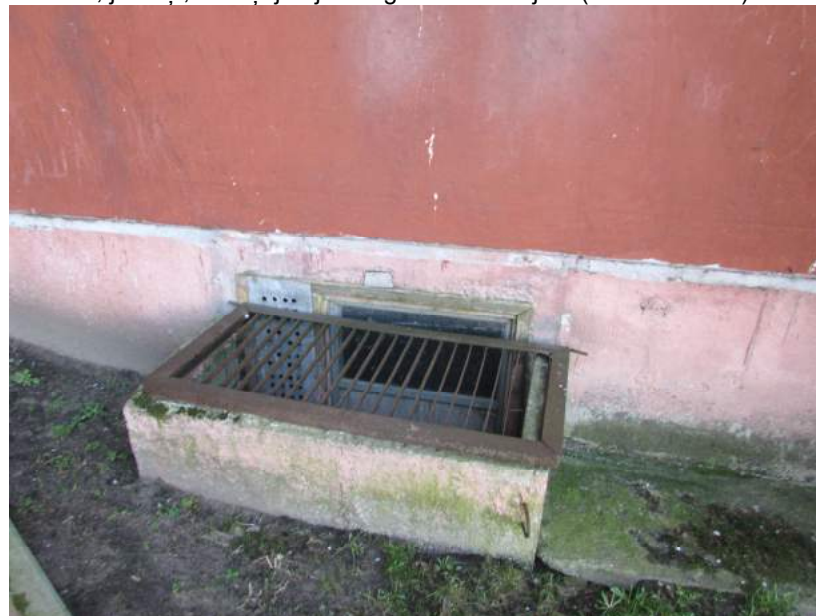
10.,11.att. Soliņi demontējami, atbalstsienu virsma atjaunojama; metāla detaļas jāapstrādā pret koroziju; pagraba logi pie nomaiņas jāsamazina, šahtas jādemontē.
