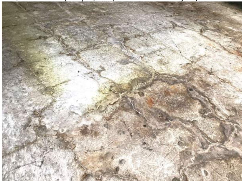
23.,24.att. Trijiem jumta paneļiem konstatēti bojājumi visā apakšējā virsmā; remonts veicams, negaidot mājas atjaunošanas darbu sākumu. Vietām paneļos ir robi.
