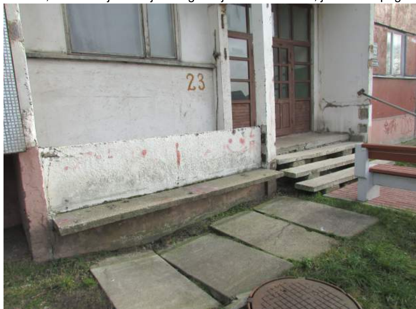
10.,11.att. Soliņi demontējami, atbalstsienu virsma atjaunojama; metāla detaļas jāapstrādā pret koroziju; pagraba logi pie nomaiņas jāsamazina, šahtas jādemontē.
