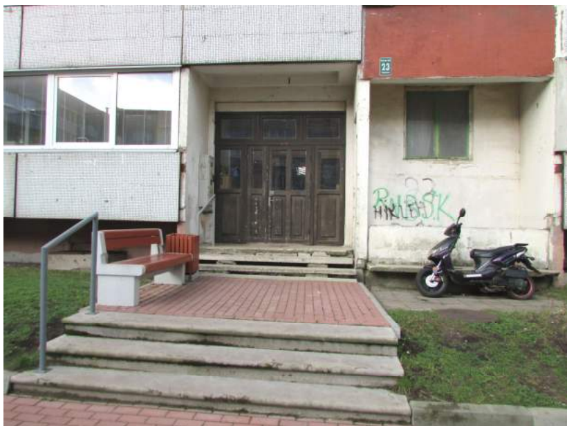
8.,9.att. Ārējiem ieeju mezgliem jāmaina ārdurvis, jāremontē pagrabu stabi, atbalstsienas, jumtiņi; lieveņi jāatjauno galvenām ieejām (kreisias attēls).
