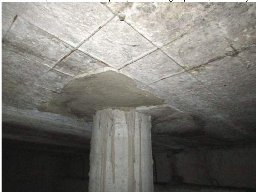
27.,28.att. Jumta paneļiem izvadu vietās atsegts stiebrojums, ir plaisas, mitruma plankumi.
