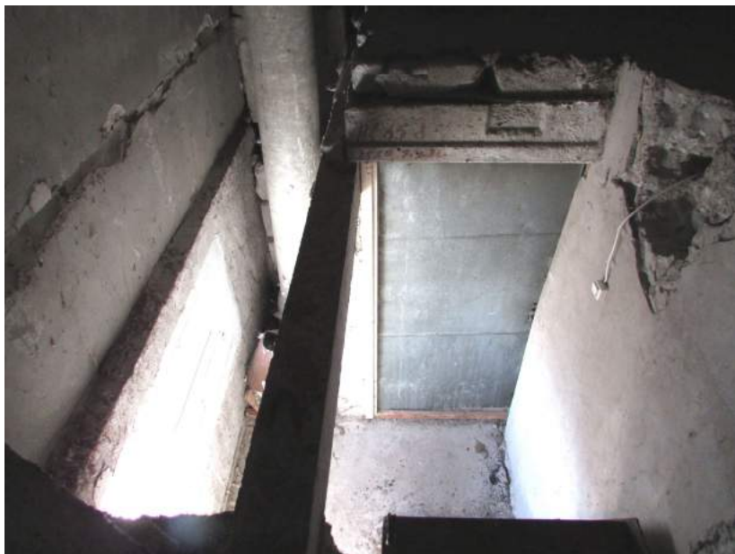
17.,18.att. Ieejas bēniņos ierīkotas no visām kāpņu telpām caur durvīm, kas jānomaina. Kāpnes uz jumta lūku, kuru vāki jānomaina; paneļu virsma nomelnējusi.
