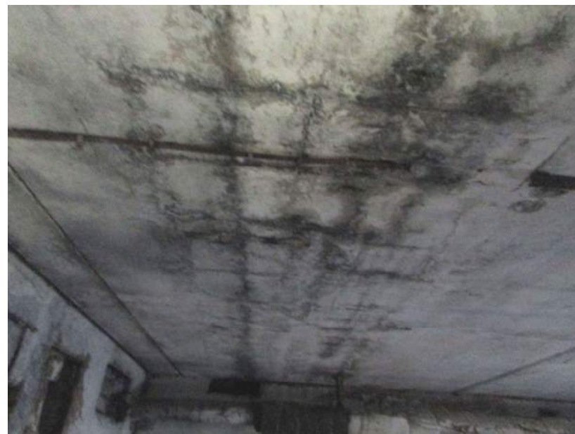
12.,13.att. Pagraba pārsegums jāsilina, atvērto kabelus no griestiem. Bojātais panelis asīs M-N/2-3 jāremontē; redzamas vairākas plaisas, bojāta virsma.
