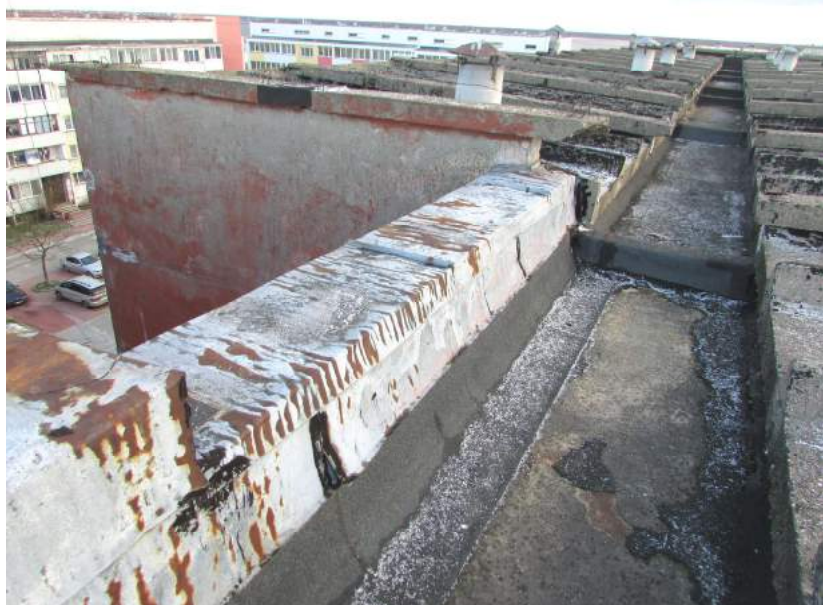
35.,36.att. Parapeti jāremontē, jāapšuj ar skārdū; pēc ruberoīda noņemšanas jāprecizē bojājumi. Uz lodžiju jumta virsmas redzams apsūņojums; segums tiks mainīts..
