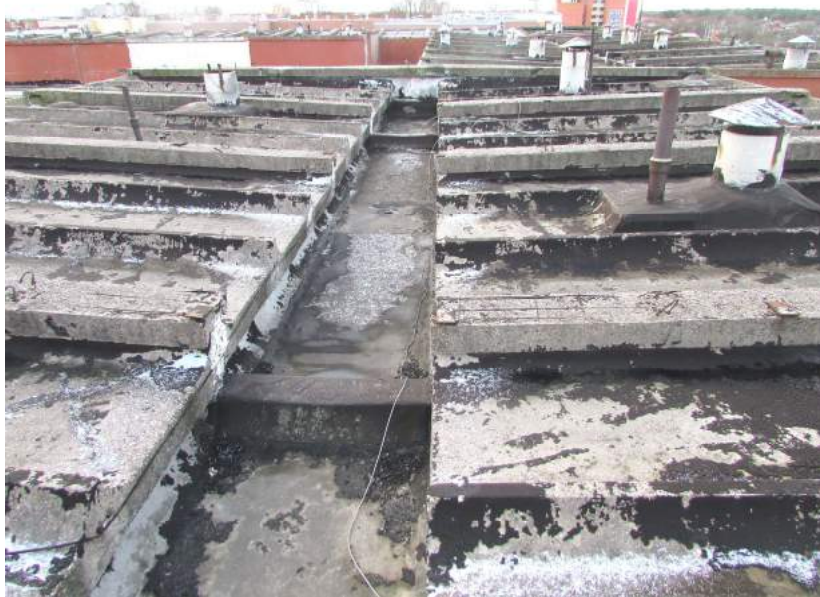
31.,32.att. Jumta elementu bojājumu apmēru jāprecizē pēc ruberoīda noņemšanas; jumtiņiem ir stiegu atsegumi; lūku vāki, skārda jumtiņi nolietojušies..
