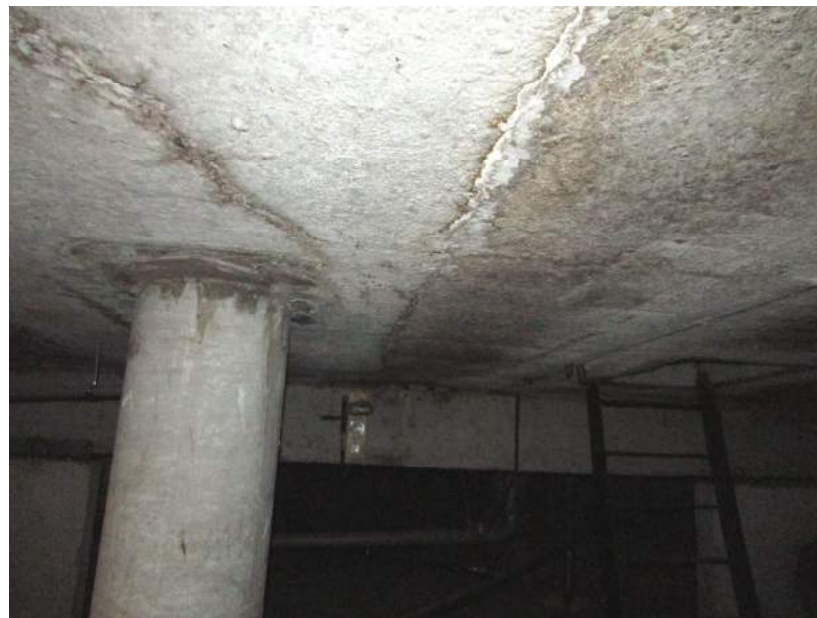
21.,22.att. Jumta paneļu apakšējā virsma mitruma bojāta plašos laukumos: konstatētas plaisas, stiegru atsegumi, nomelnējums kondensāta mitruma iespaidā.
