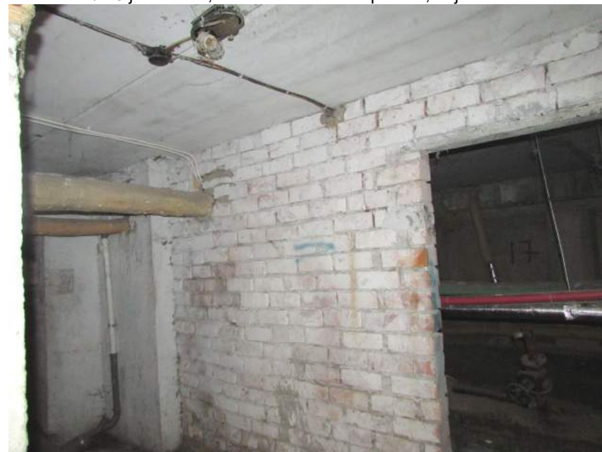
14.,15.,16.att. Saglabājamo šķūnīšu sienu augšdaļa jādemontē; pagrabā redzami nenomainīti inženiertīkli; dažas starpsienas mūrētas..
