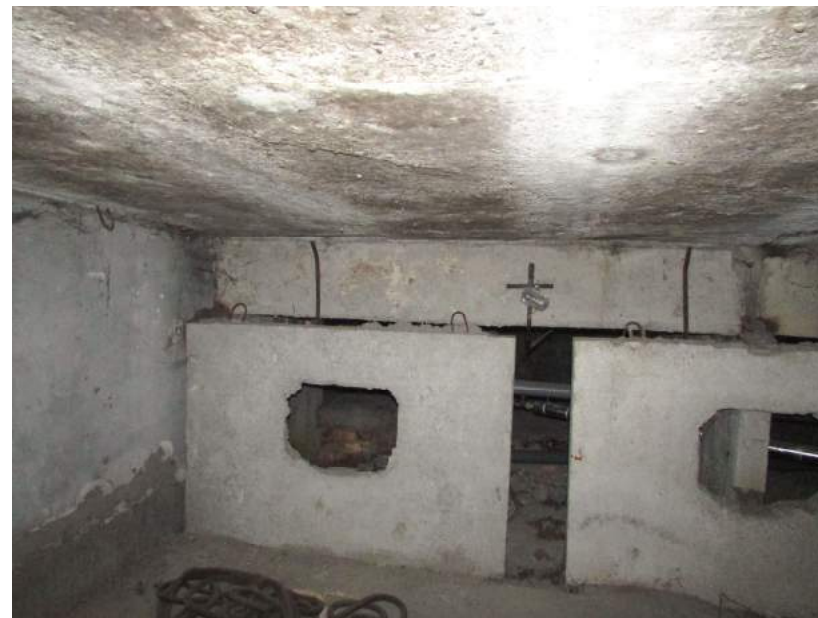
25.,26.att. Daudziem paneļiem raksturīgas plaisas, 3 tumšas joslas, betona saistvielu izskalojumi u.c.defekti, kas jānovērš remontdarbu laikā.
