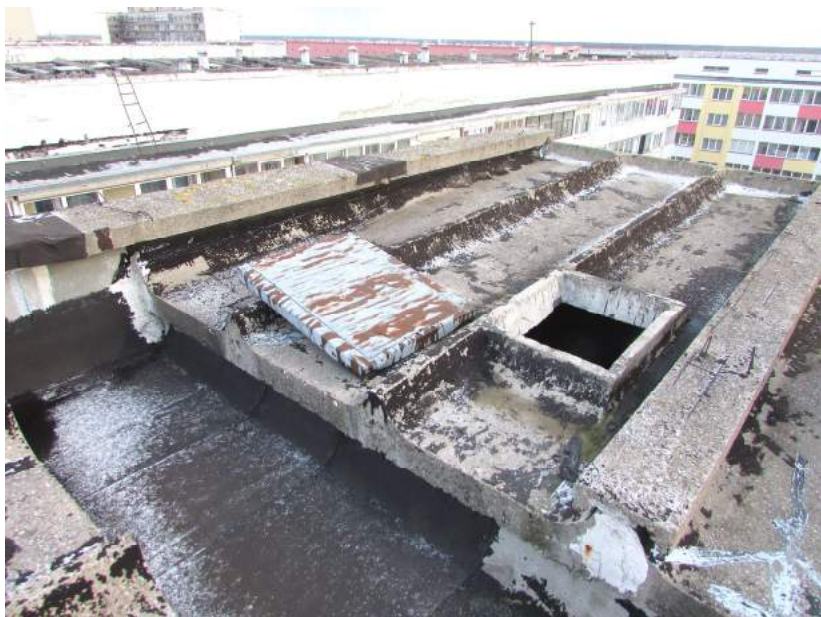
29.,30.att. Dzelzsbetona jumta kopskats; visi jumta elementi-paneļi, jumtiņi, margas, parapeti-daļēji nolietojušies; bojājumu vietas nosegtas ar ruberoīda ielāpiem.
