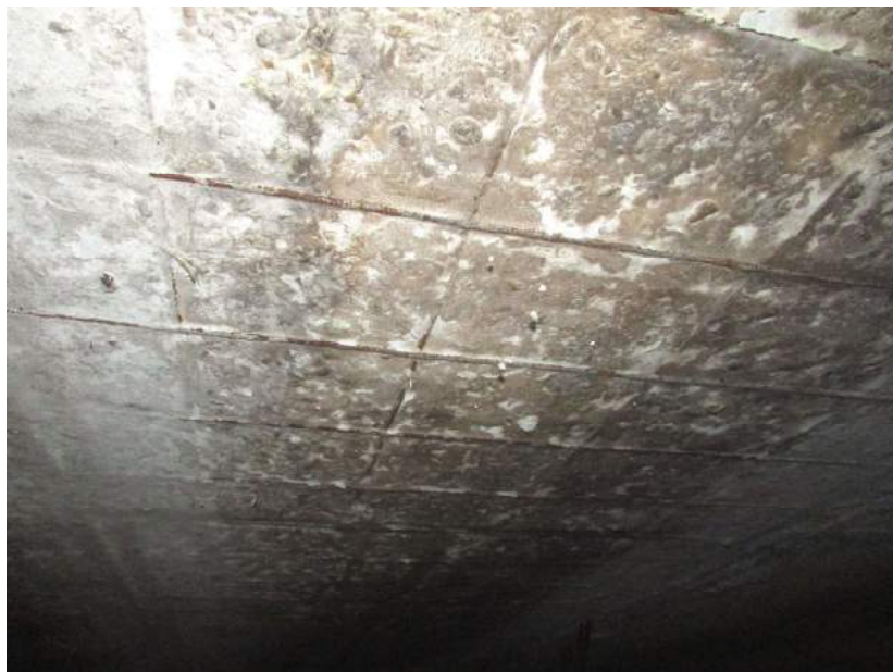
21.,22.att. Jumta paneļu apakšējā virsma mitruma bojāta plašos laukumos: konstatētas plaisas, stiegru atsegumi, nomelnējums kondensāta mitruma iespaidā.
