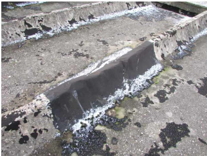
33.,34.att. Vienam panelim bojāta riba; lielākie defekti nosegti ar ruberoīdu. Vairākiem jumtiņiem atsegts stiegrojums. Jumta virsma jāatjauno visā platībā.
