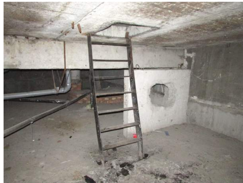
17.,18.att. Ieejas bēniņos ierīkotas no visām kāpņu telpām caur durvīm, kas jānomaina. Kāpnes uz jumta lūku, kuru vāki jānomaina; paneļu virsma nomelnējusi.
